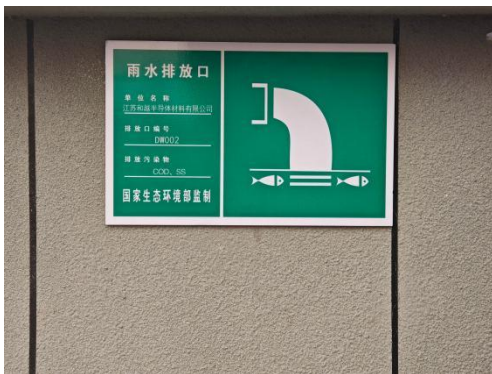
雨水排放口标识牌
