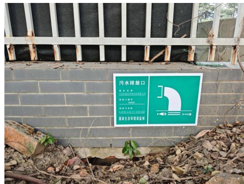
污水排放口标识牌
